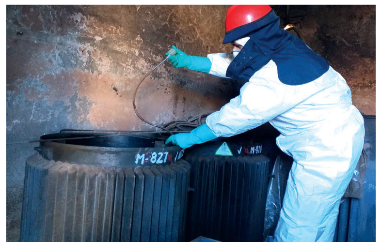
Etapa de muestreo de aceites dieléctricos de los equipos sospechosos de contener Bifenilos Policlorados (PCBs), para realizar el ensayo electroquímico.
