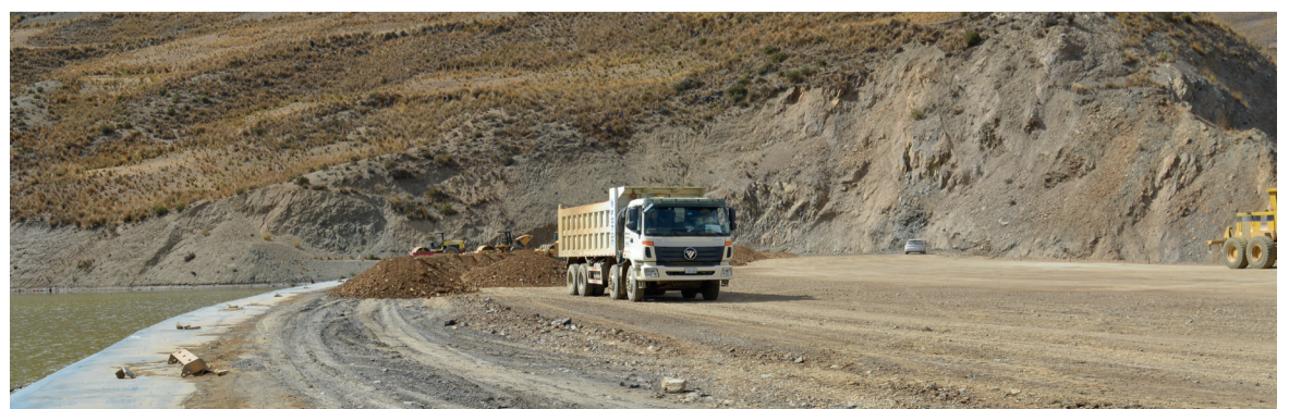
Trabajos que se realiza en el Dique de Colas E.M. Colquiri
