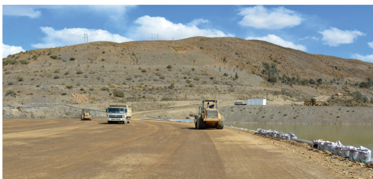
Trabajos que se realiza en el Dique de Colas E.M. Colquiri
